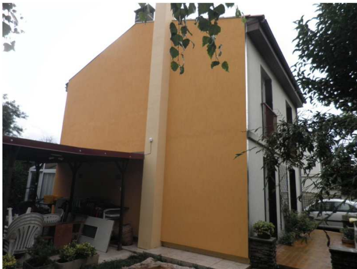
Isolation du mur nord avec 11cm de polystyrène 5274€ HT
