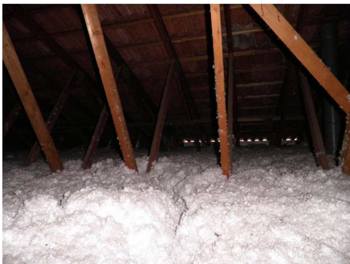
Insufflation de 30cm de ouate de cellulose (photo de chantier) Rehausse de trappe d'accès 2071€
