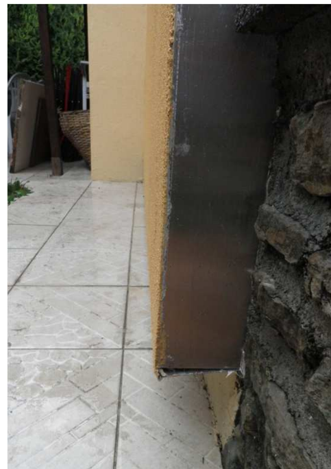
Isolation du mur nord avec 11cm de polystyrène 5274€ HT
