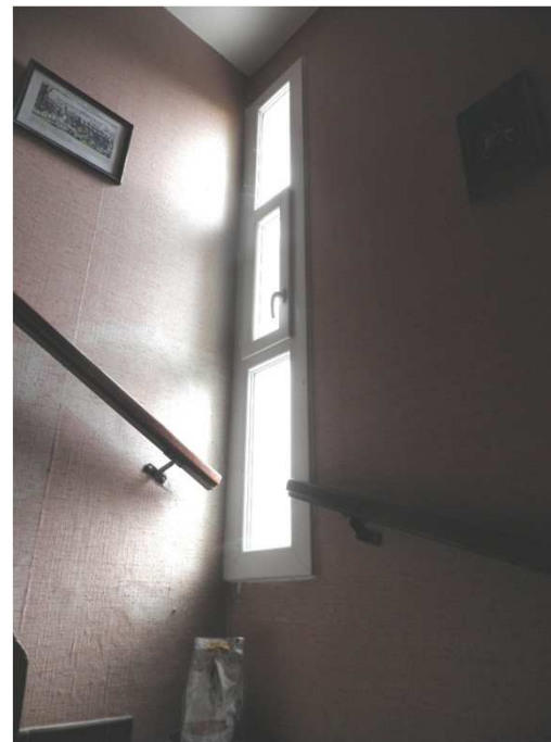
Changement de la menuiserie de la cage d'escalier
