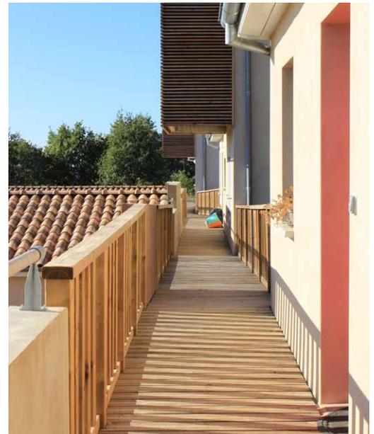
**Une passerelle en bois traverse horizontalement l'opération et dessert les logements du niveau intermédiaire des îlots du haut**
