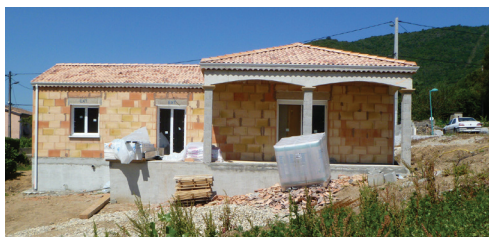
Maison en construction, Flaviac, Ardèche
