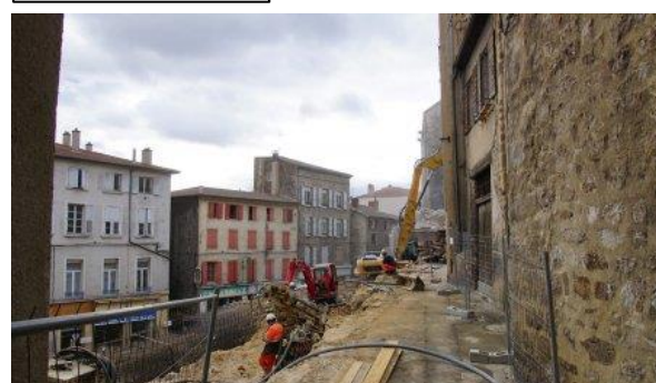
Démolition sur l'îlot de Boissy d'Anglas
