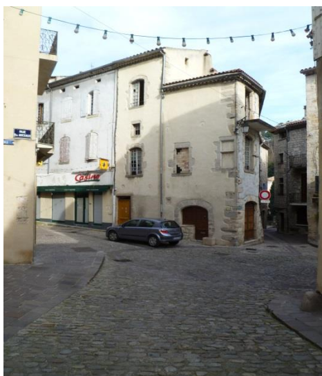
Habitations vacantes sur le centre ancien de Largentière
